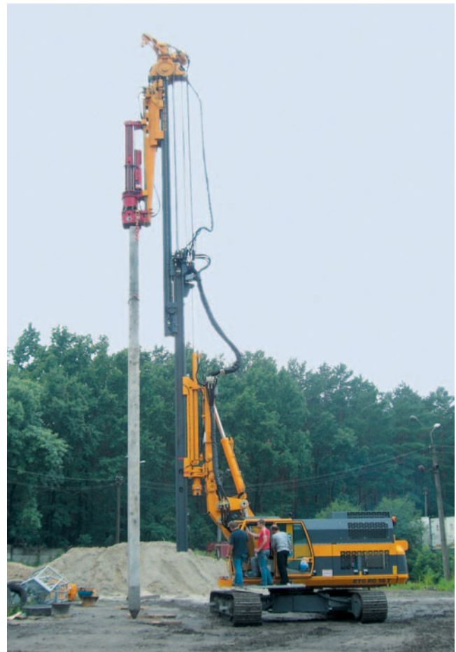
RG 16 T с гидравлическим молотом FAMBO RG 16 T with FAMBO hydraulic hammer (Ukraine)
