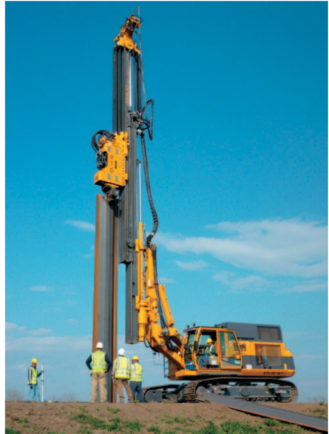
Установка шпунтовой стены, вибратор MR 125V-01 RG 19 T Sheet pile installation with vibrator MR 125V-01 on RG 19T (USA)
