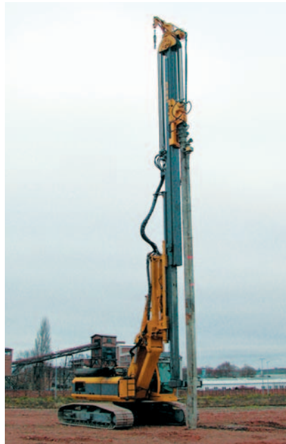
RG 18 T с глубинным вибратором TR 17 (создание подземных бетонных свай) RG 18T with deep vibrator TR 17 (vibrated concrete columns) (Leipzig, Germany)
