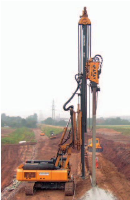
Выполнение узких стенок с помощью RG 18T Construction of VIB-wall with RG 18T (Mainz, Germany)
