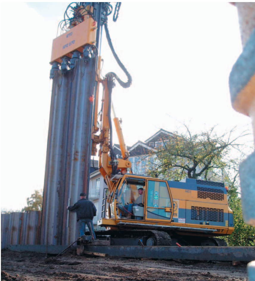
RG 16 T с прессом MPZ 670 (Восстановление дамбы в г. Ашаффенбург) RG 16 T with press MPZ 670 (Dike rehabilitation) (Aschaffenburg, Germany)
