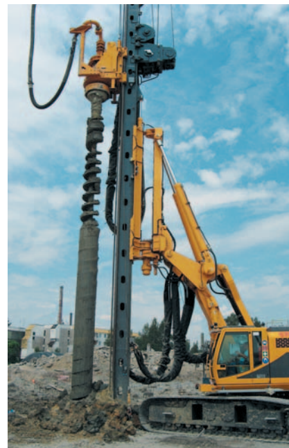
Установка свай методом SOB (23 м) с RG 25 S CFA piling (depth 23 m) with RG 25 S (Krakow, Poland)
