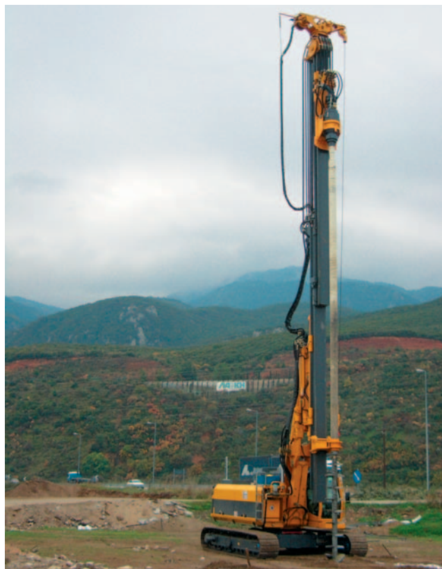
Перемешивание грунта одной лопастью на RG16T Single column mixing with RG 16T (Greece)
